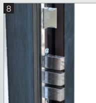
8 Zamek listwowy klasy 4 z blokadą klamki z zabezpieczeniem górnym i dolnym
