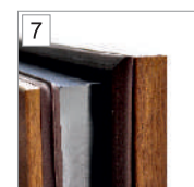
Przegroda termiczna, dwie uszczelki w skrzydle
