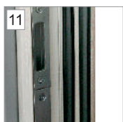
Przegroda termiczna, dwie uszczelki w ościeżnicy
