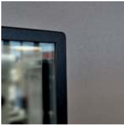
Zlicowana wąska ramka od strony zewnętrznej
