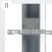
11 Elementy wzmacniające konstrukcję ościeżnicy z kotwami montażowymi
